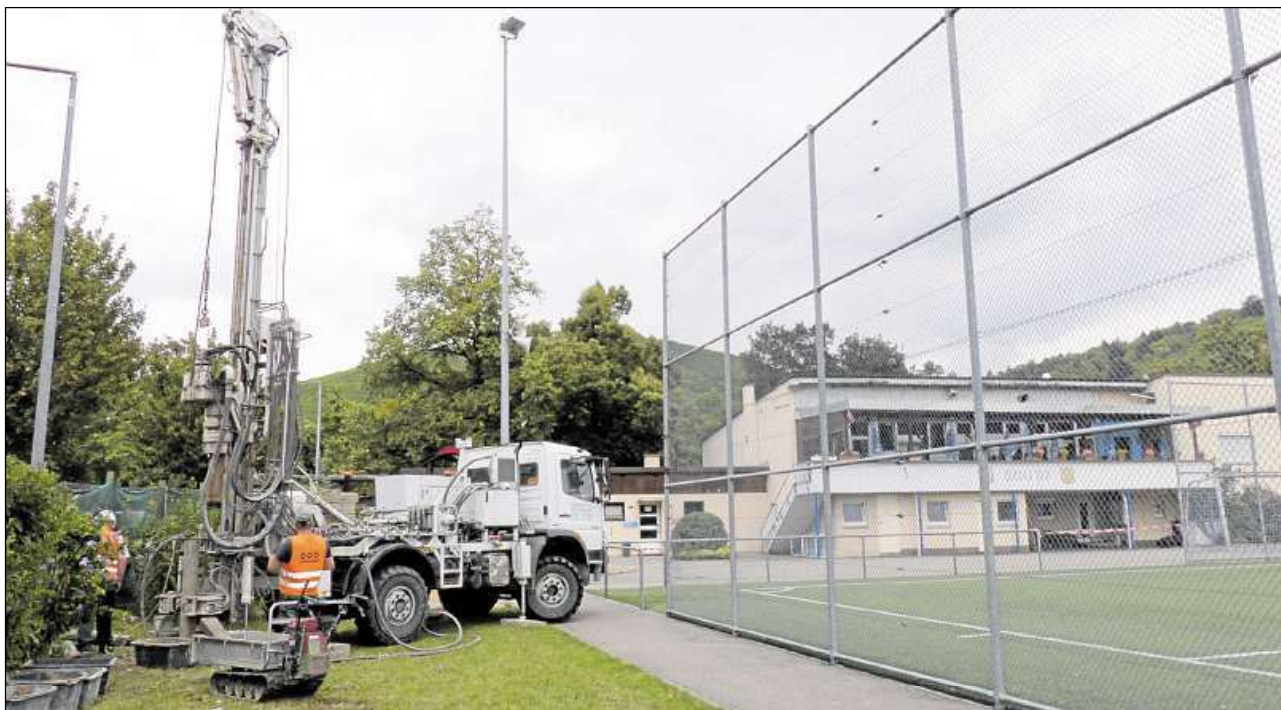
Bereits Anfang September war ein großer Bohrer auf dem SGU-Gelände im Einsatz. Damals wurde Beton in einen Hohlraum gefüllt.
